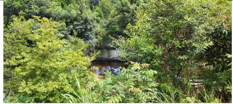
矿山事故应急池
