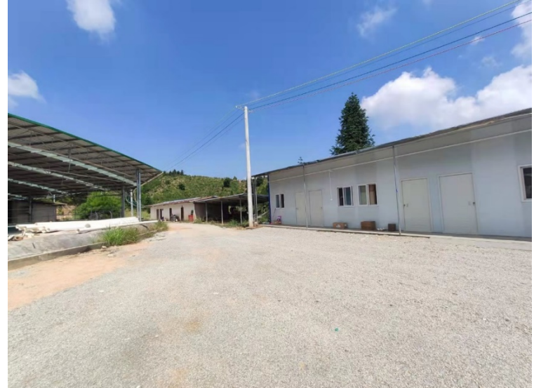
一般固废间和办公区
